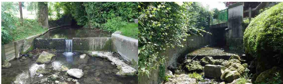
Exemples d'ouvrages hydrauliques freinant la libre circulation piscicole et sédimentaire (gauche : seuil d'alimentation du lavoir de Saint Siméon ; droite : seuil du pont de Saint Siméon ; crédit photo : banque de données geobs).
