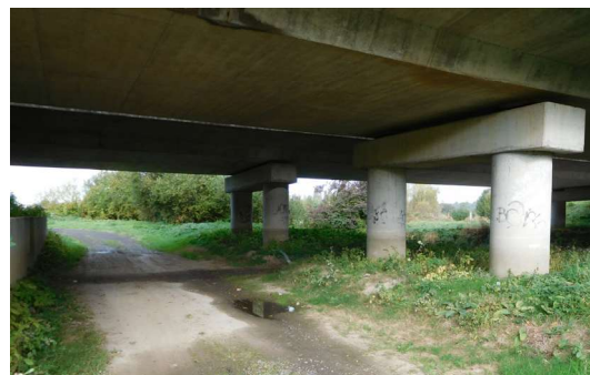
Passage sous l'autoroute
